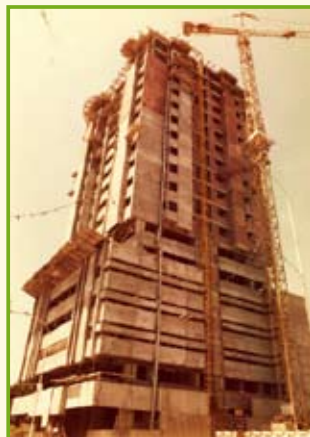
المقر قيد الانشاء Siège en construction
